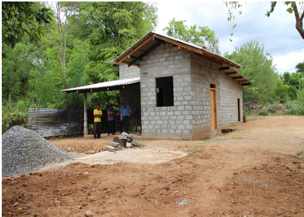
UWWO 事務所裏手に建設されたばかりのマーケティングセンターと建設前の土地(下写真・6月)
